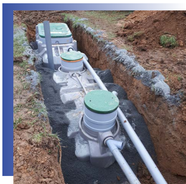
↳ Filtre compact en ligne Exemple d'installation photographiée lors d'un contrôle avant remblaiement
