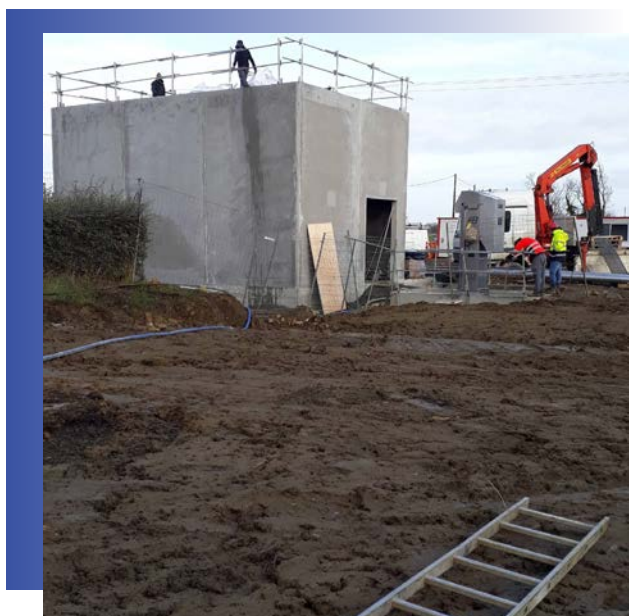
↳ Réhabilitation du poste de refoulement de la Magdeleine situé à Thouars,
